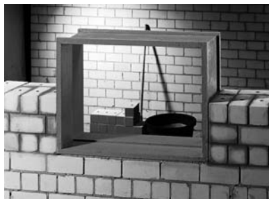
Ablakkeret beállítása a beépítési magasságnak megfelelően
