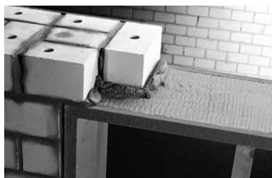
Stabil, alaktartó kötést kell létrehozni
